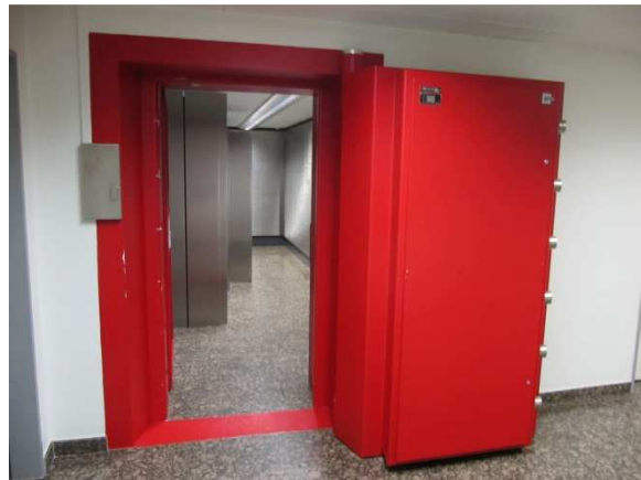
Bild 18: Tresorraum einer Bank, Deutschland
