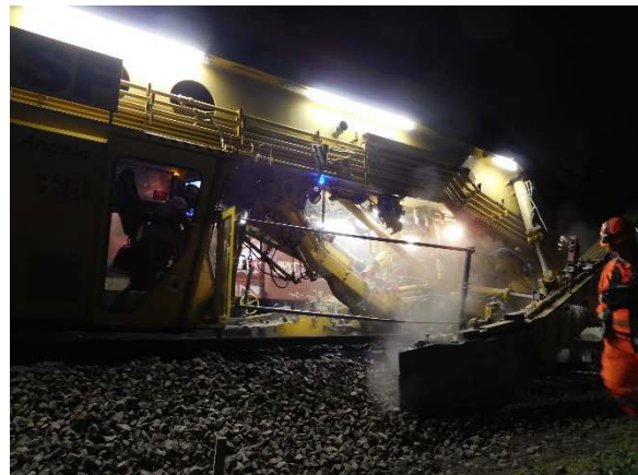
Bild 7: Arbeiten an einem Eisenbahngleisbett, Frankr.
