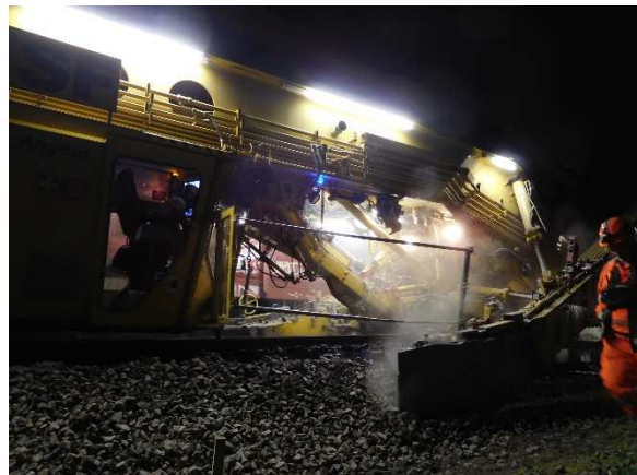
Bild 7: Arbeiten an einem Eisenbahngleisbett, Frankr.
