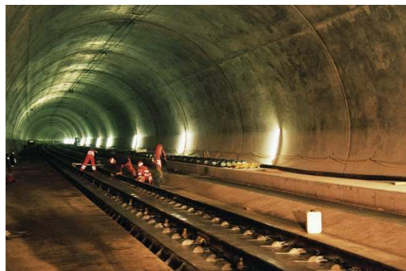
Bild 11: Bauarbeiten in einem Tunnel, Deutschland
